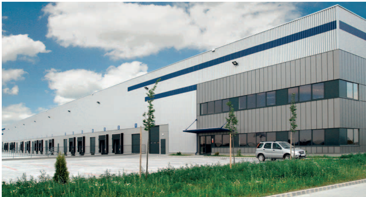
Moderne Anlagen gehören zu den Dauerbrennern am Markt für Logistikimmobilien.
